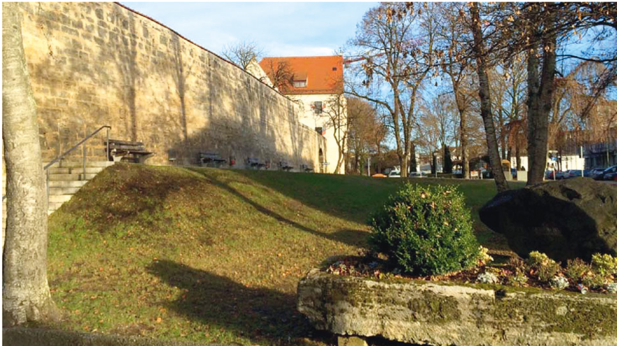
An der sanierten Stadtmauer können die Weilheimerinnen und Weilheimer wieder die Sonne genießen.
